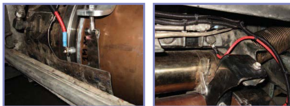
Figur 3 & figur 4 viser det tilsluttede gløderør (venstre) og stelforbindelsen til udgangsmodul
